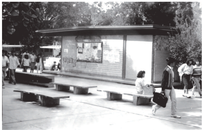
Edificio H, año 1975
